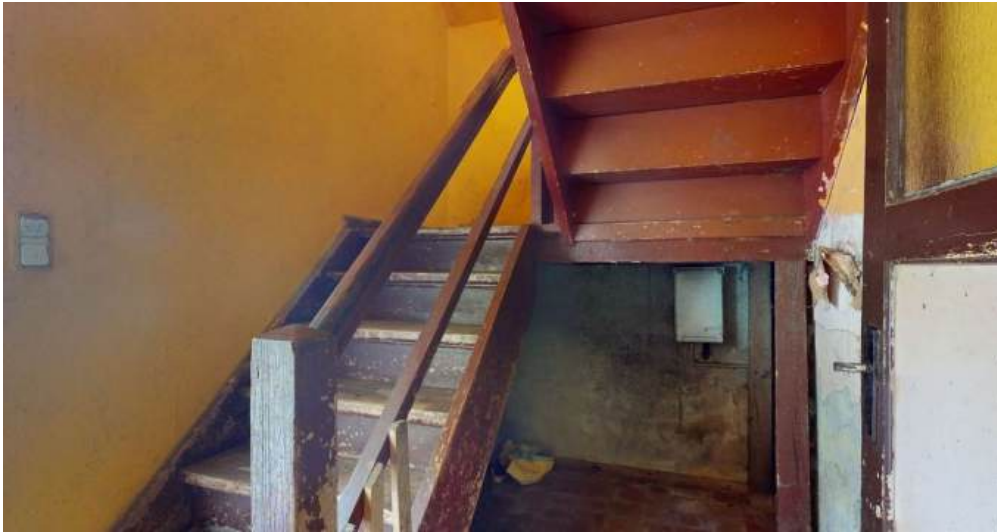
Treppe ins OG
