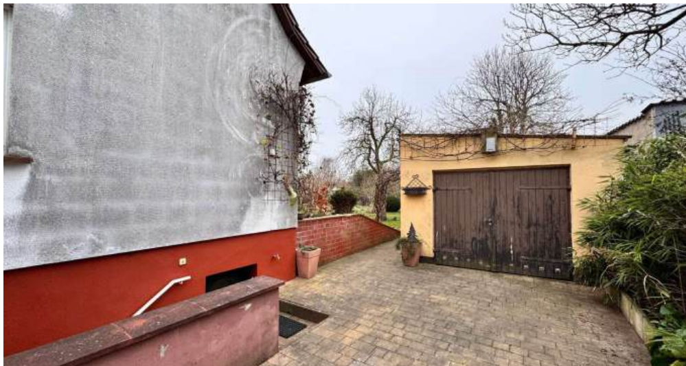
Zufahrt zur Garage
