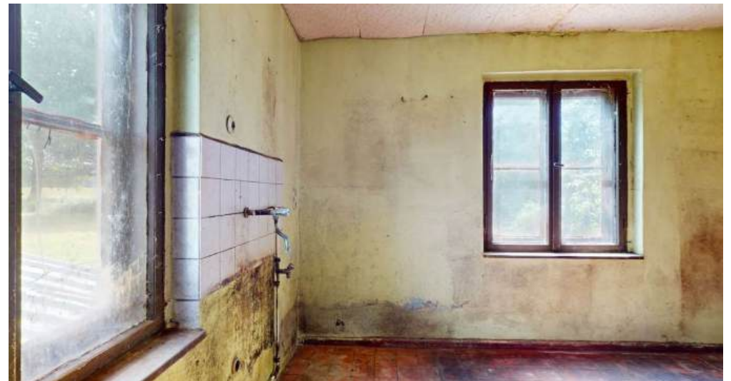
ehemalige Küche im EG
