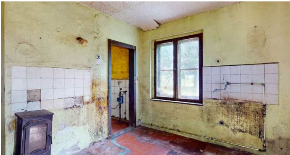
ehemalige Küche im EG
